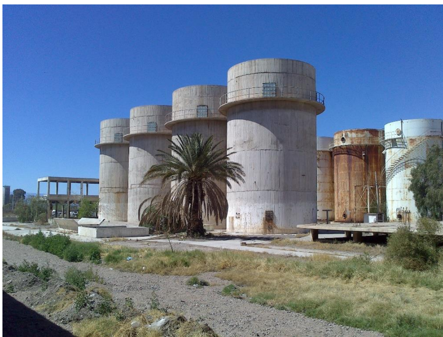
Tanques de Fermentación.
