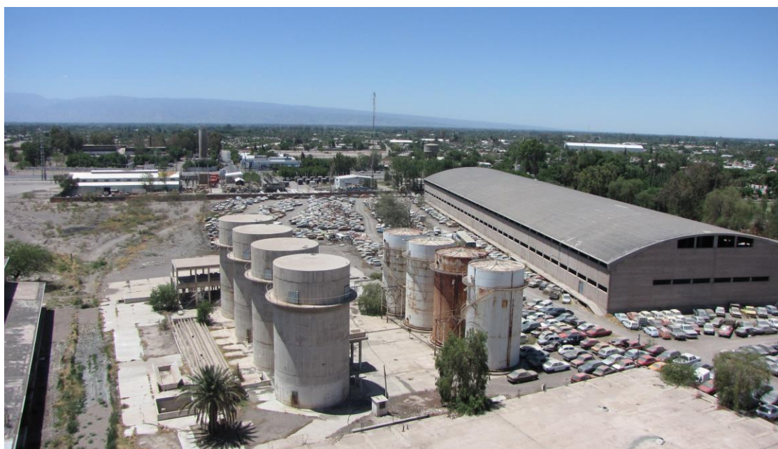
Vista desde el Tanque de Agua. Cuerpo N°5 y Tanques de fermentación.
